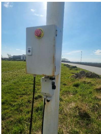
Figur 8-2 Likeretter boks montert på søylen på prototypen på Kolnes.
